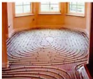
Suelo radiante por agua caliente
